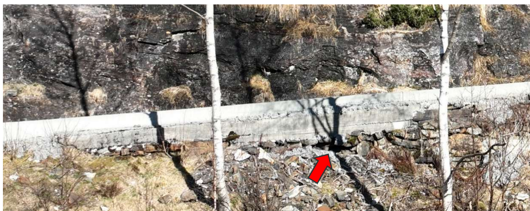
Figur 6. Det er gamle tørrsteinsmurar på strekninga. Biletet viser opne holrom i muren. Stabiliteten kan verte usikker dersom det vert mykje trafikk her.
