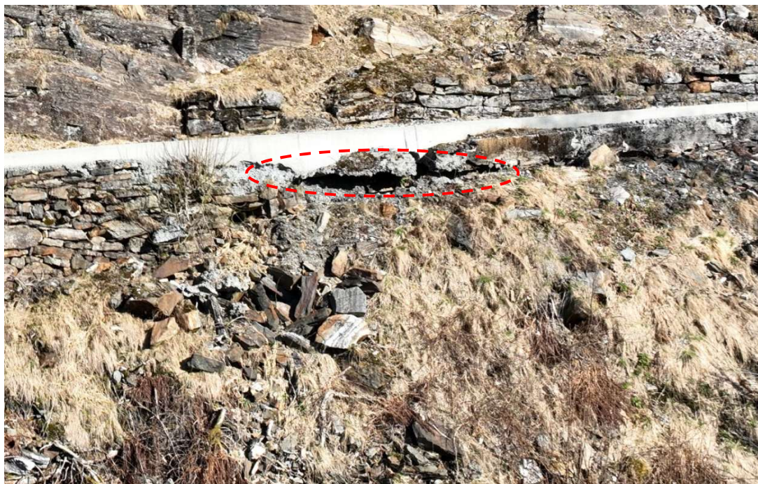
Figur 5. Det er gamle tørrsteinsmurar på strekninga. Biletet kan indiker opne holrom i muren. Stabiliteten kan verte usikker dersom det vert mykje trafikk her.
